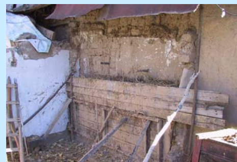
Isolationsarbeiten an einem kirgisischen Haus
